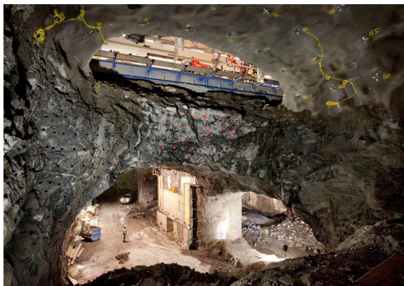
Figur 1. Citybanan passerar under blå tunnelbanelinje (Trafikverket).
