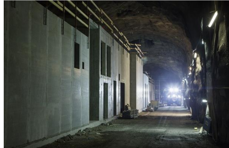
Citybanan Norrströmstunneln byggnation i servicetunnel. Trafikverket. Foto Mikael Ullén
